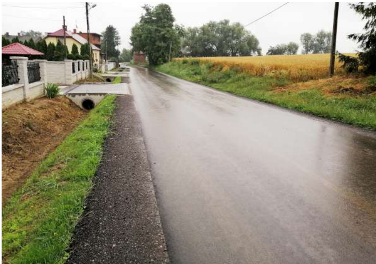
Droga powiatowa nr 1270K w miejscowości Rudno Górne po modernizacji.
