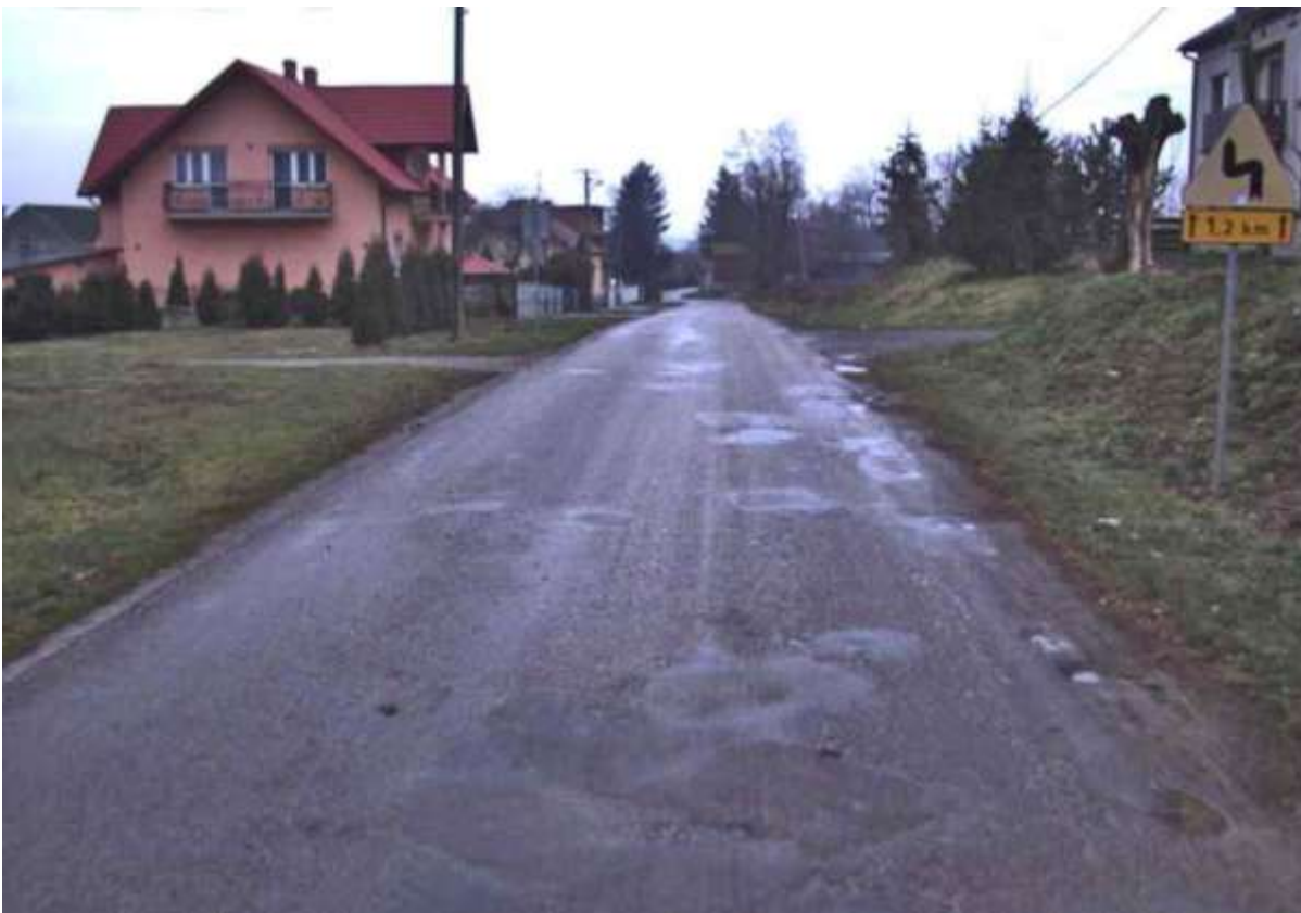
powiatowa nr 1270K w miejscowości Rudno Górne przed modernizacją.
