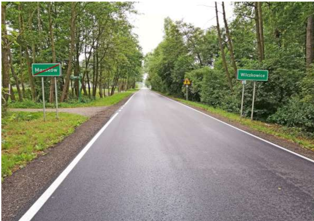
Droga powiatowa nr 1172K, Zerwana - Maszków po modernizacji.
