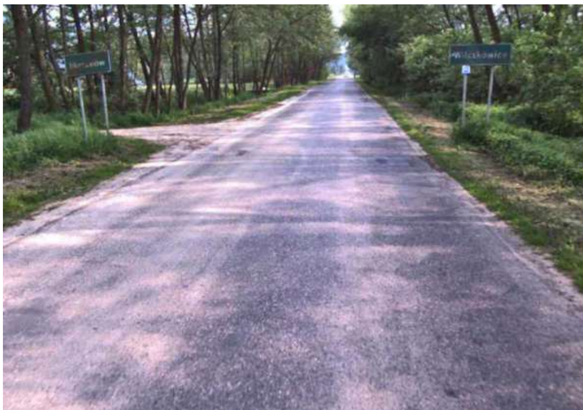
Droga powiatowa nr 1172K, Zerwana - Maszków przed modernizacją.
