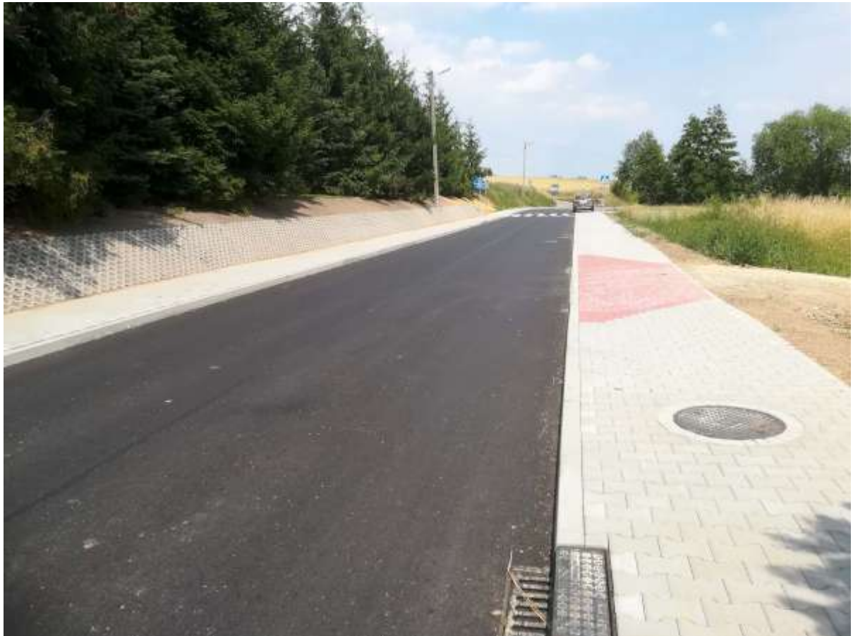
Droga powiatowa nr 2029K, ul. Lwowska w Ochojnie po przebudowie.
