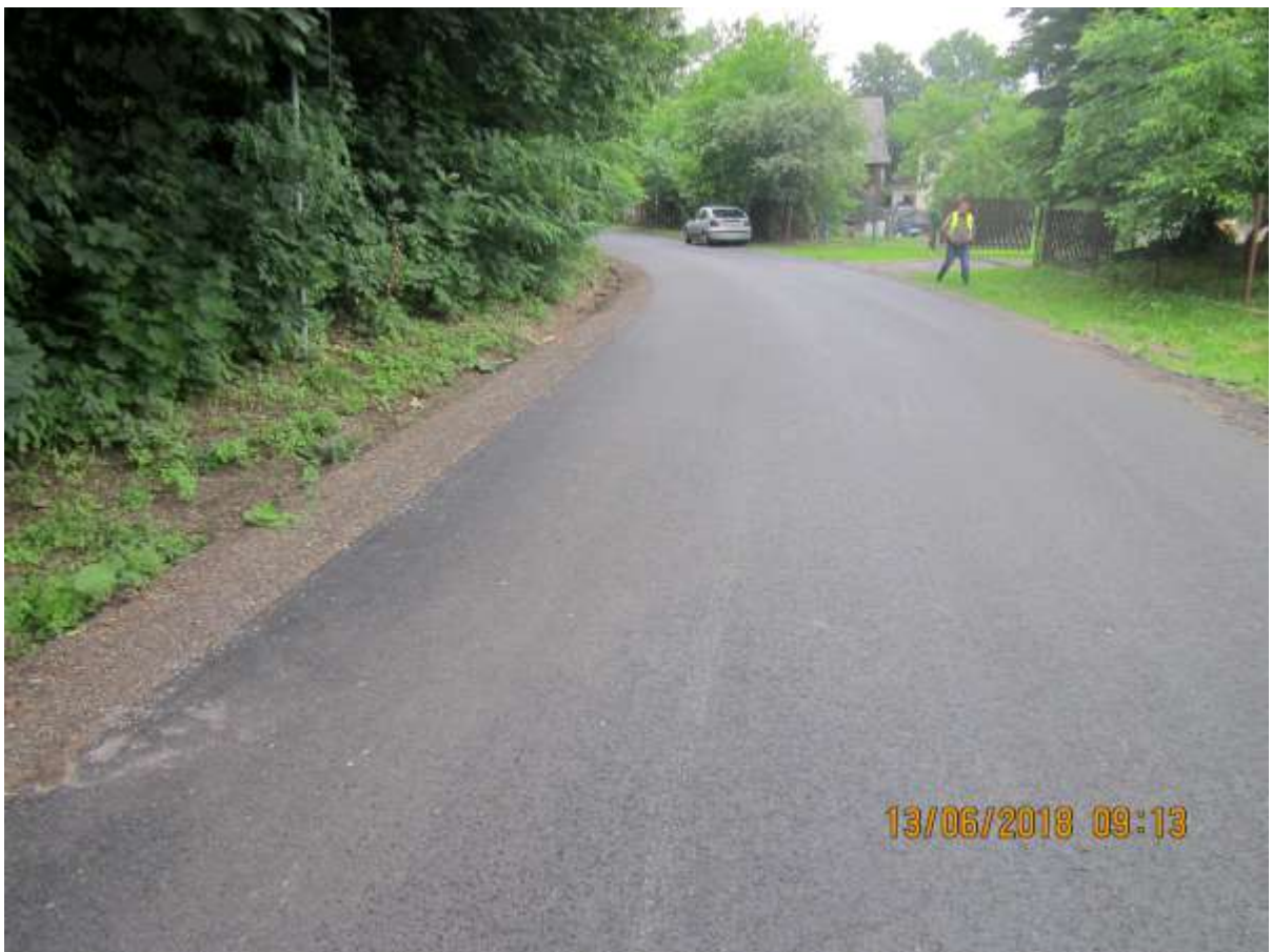
Rzeplin – droga powiatowa nr 2143K po modernizacji.
