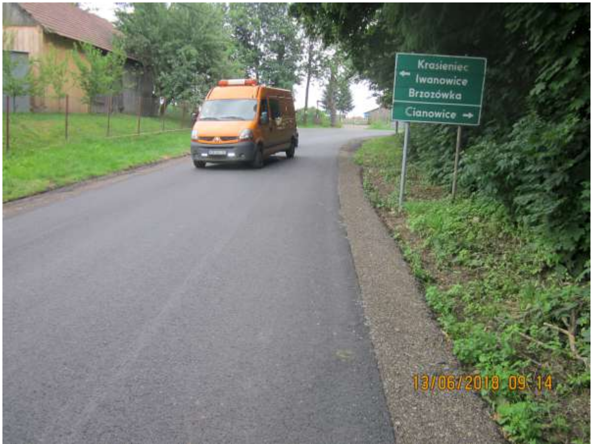
Rzeplin - droga powiatowa nr 2143K po modernizacji.
