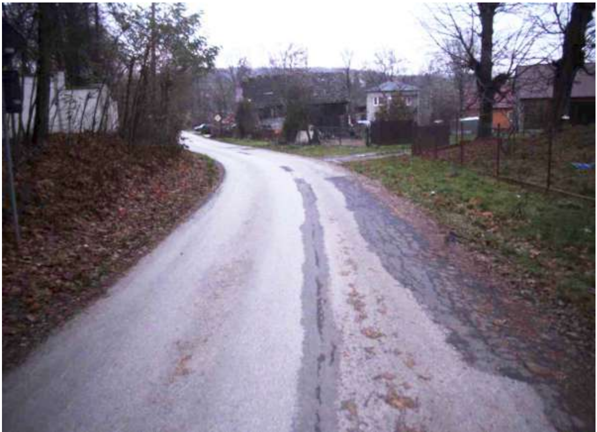
Rzeplin – droga powiatowa nr 2143K przed modernizacją.
