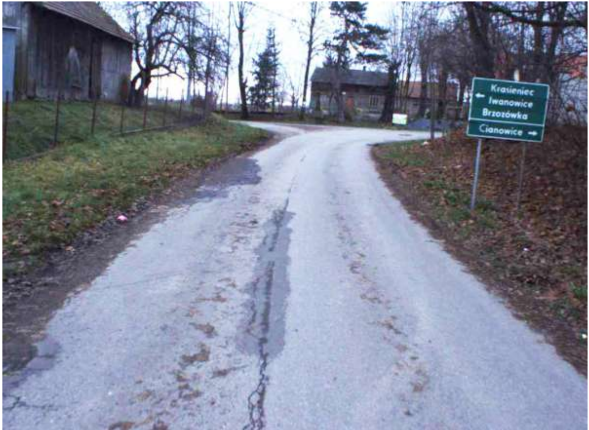
Rzeplin – droga powiatowa nr 2143K przed modernizacją.
